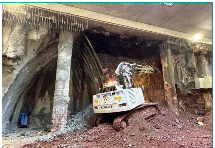
Estação de Santos
