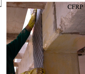
Colagem SRP ( steel reinforced polymer ) e tela CFRP nós
